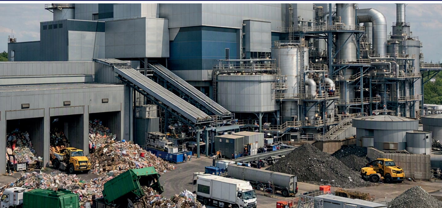
Planta incineradora de residuos
